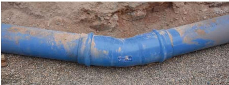
монтаж и ручные манипуляции с ними вплоть до диаметра DN250 мм; повышенную устойчивость к гидравлическому удару за счет меньшей скорости потока; превосходную стойкость к механическим ударам; герметичность, благодаря которой предотвращаются утечки из системы, а следовательно, потери воды, способные привести к уменьшению объема ее подачи.
