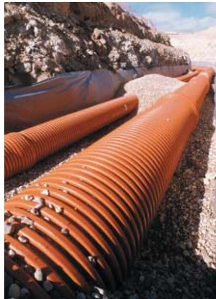
*Канализационная система Sanecor® из гофрированных ПВХ-труб*
