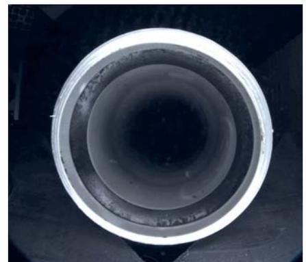
Рисунок 1. Правильная установка уплотнителя
