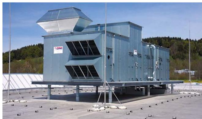
воздуха используется, например, бесплатное тепло, отходящее от контуров водяного охлаждения. Поэтому конструкция воздухотехнического оборудования ONI, хоть и нацелена в первую очередь на выполнение требований к необходимому качеству воздуха, в том числе дает возможность оптимизировать потребление энергии за счет использования бесплатных источников энергии с помощью систем ONI для рекуперации тепла.
