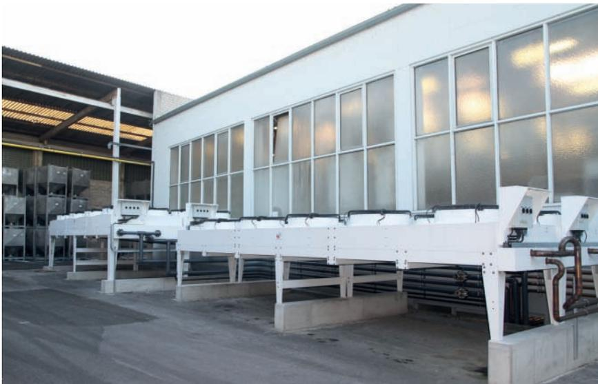
Bei der Split-Kälteanlage sind die Kältemittel-Verflüssiger im Außenbereich installiert. Freikühler nutzen in der kühlen Jahreszeit die Umgebungskälte – das spart Energie
