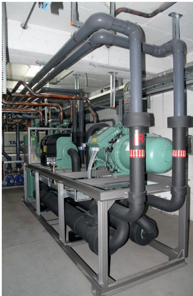
*Die neue Kälteanlage bei OBO Bettermann ist mit der VariKon-Steuerung ausgerüstet. Sie passt selbsttätig die Kondensationstemperatur an die Außentemperatur an*
