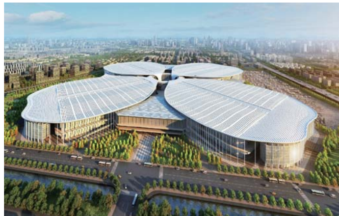
Новый Национальный выставочный и конгресс-центр (NECC) в Шанхае представляет собой крупнейший в мире выставочный комплекс, размещенный в одном здании
