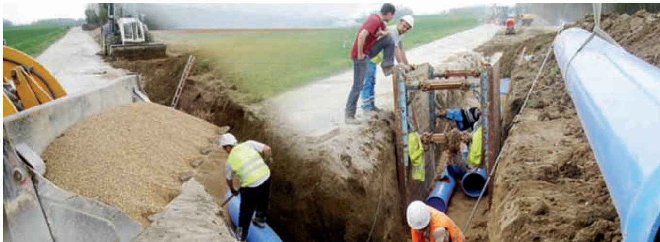
Укладка ПВХ-О труб
