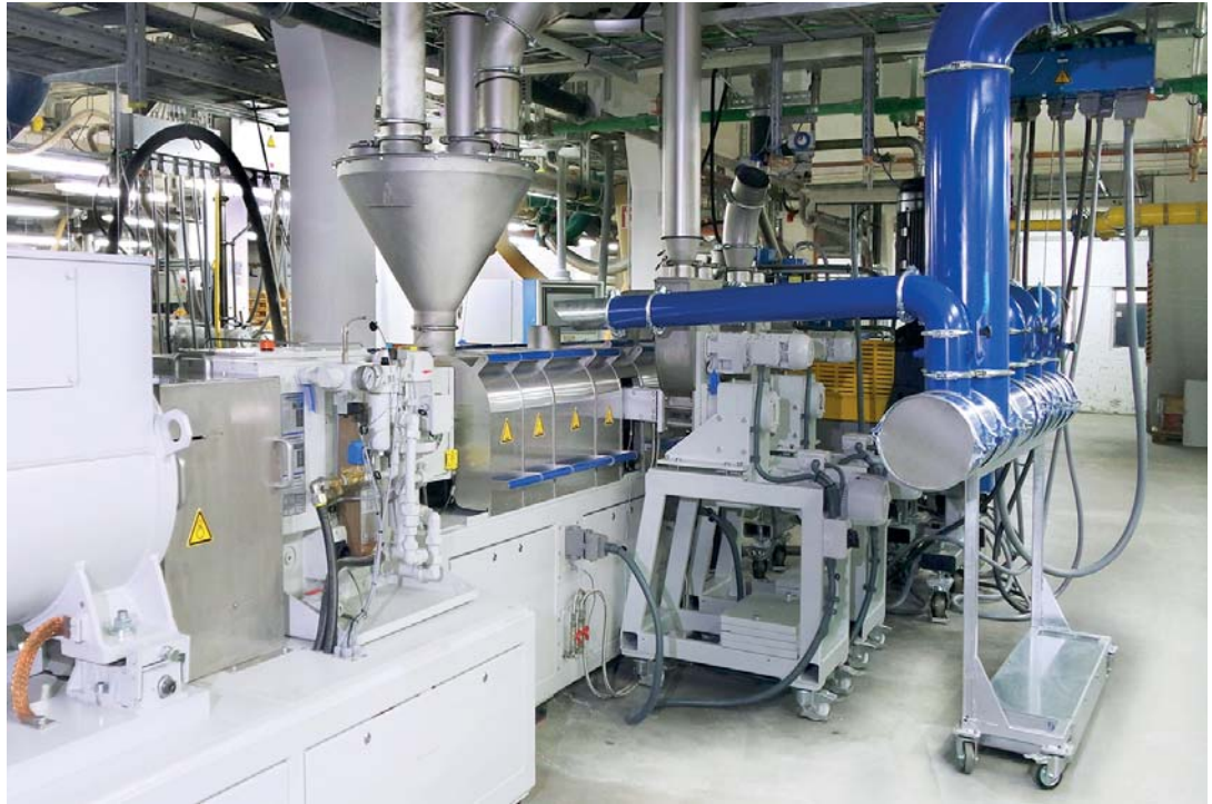
Устройства бокового дозирования в процессе работы
