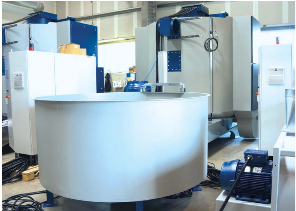
Рис. 1. Процесс изготовления двух установок DRD 26. На переднем плане накопительный бункер для загрузки материала, на заднем – камера центрифуги с электрическим шкафом и шкафом управления (фото: Р. Бауэр)
